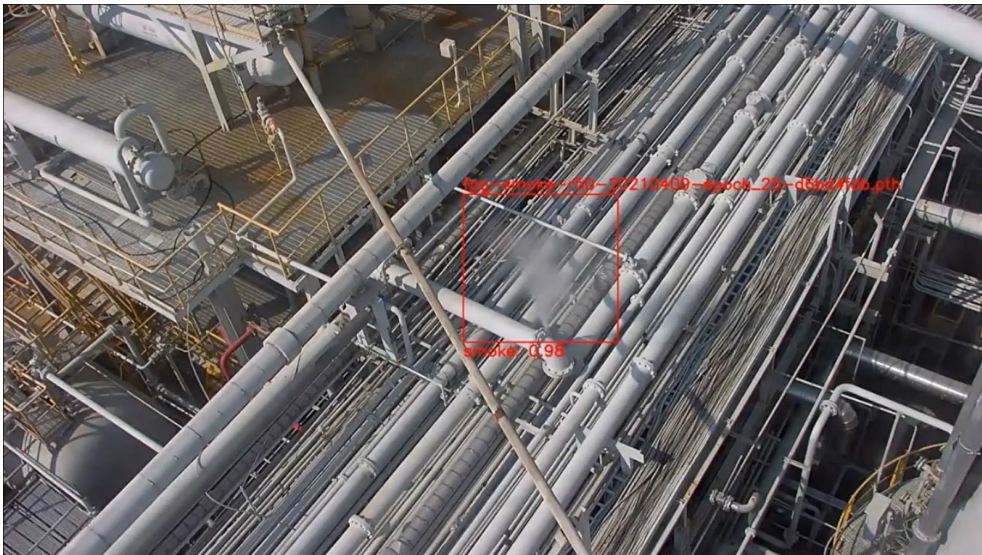
圖 19、氣體洩漏 AI 辨識圖[21]
