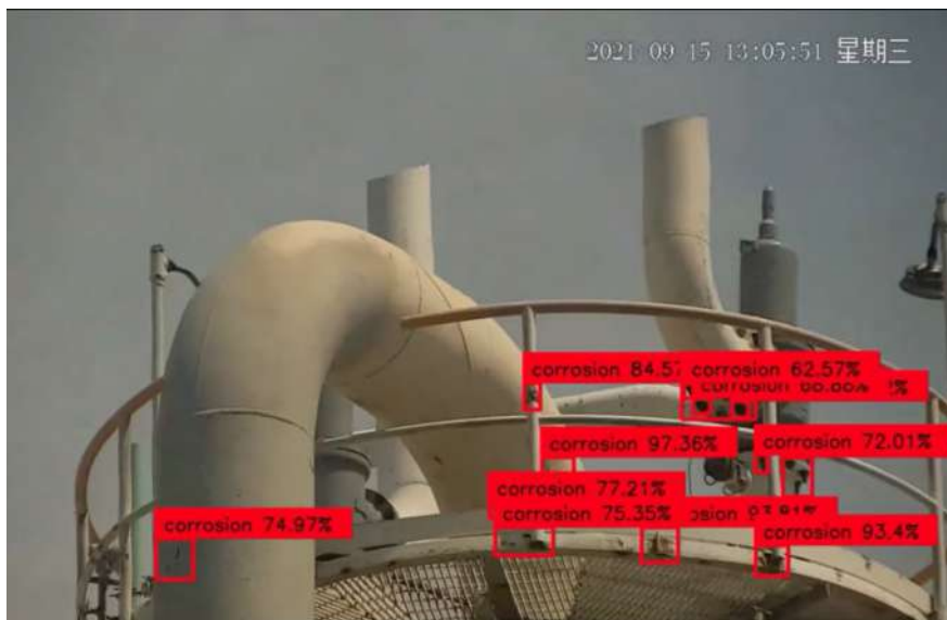
圖 20、管線銹蝕 AI 辨識圖[22]
