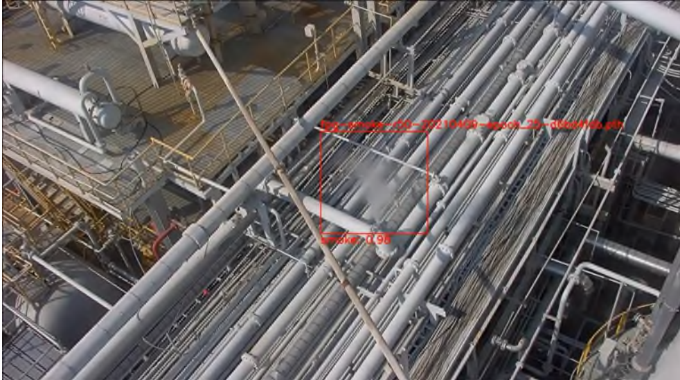
圖 19、氣體洩漏 AI 辨識圖[22]
