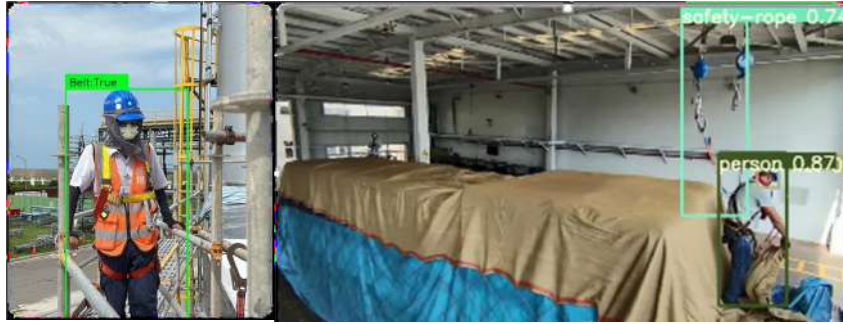
圖 7、應用影像辨識技術對高空作業進行防護具辨識圖[7]
